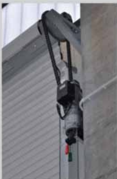
Motore laterale con rinvio a catena
